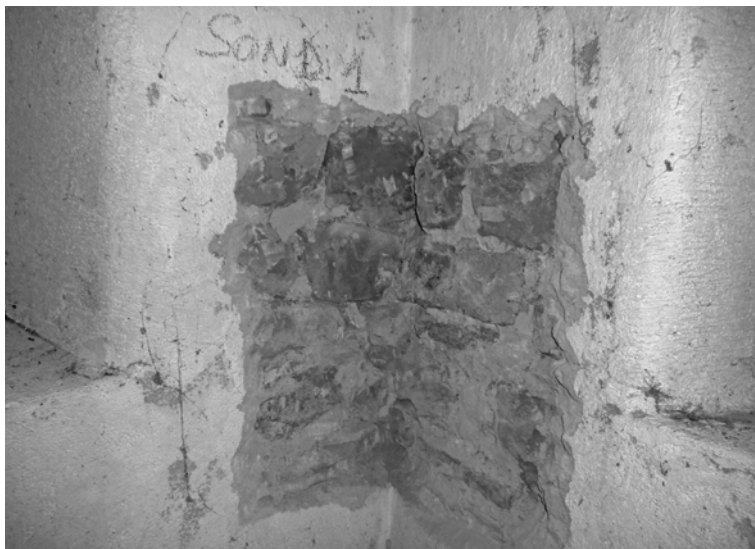
Figura 3.1. Ispezione diretta tessitura muraria
