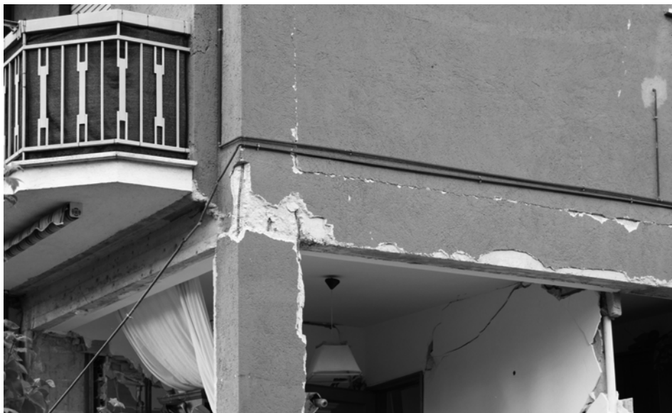
Figura 4.1. Nodo danneggiato struttura intelaiata in c.a. (Amatrice 2016)
