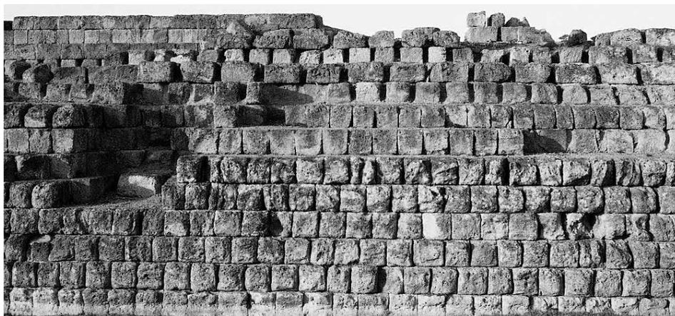
*Muro di contenimento delle terre*
