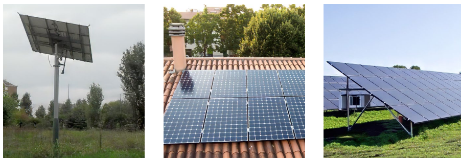
Figura 8.1. Esempi di strutture di supporto dei moduli fotovoltaici: ad inseguimento, fisse su copertura, fisse a terra
