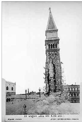
Crollo del campanile di San Marco
