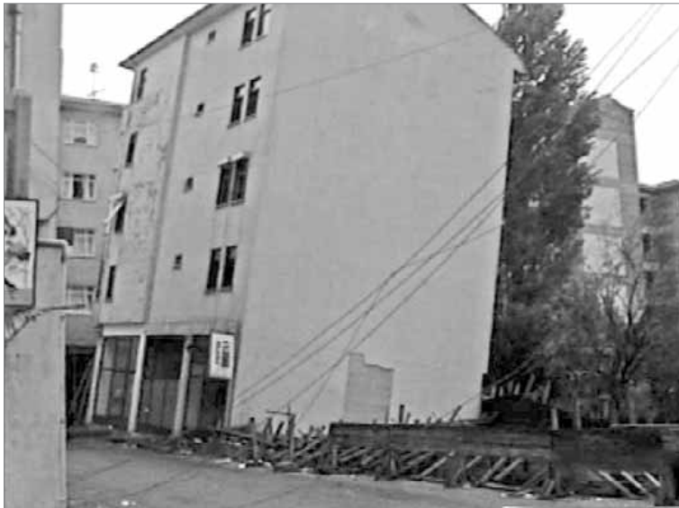
Edificio ribaltato lateralmente per rottura del terreno di fondazione
