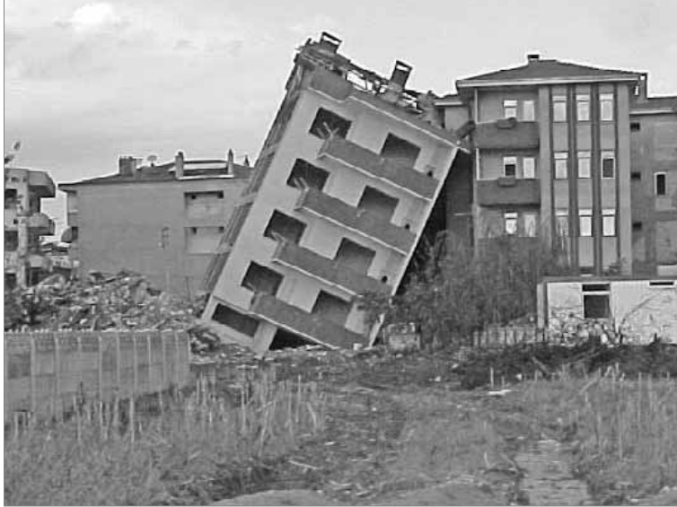
Edificio ribaltato su un fianco per rottura del terreno di fondazione
