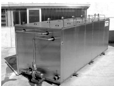
Figura 11.1. Vasca di accumulo
