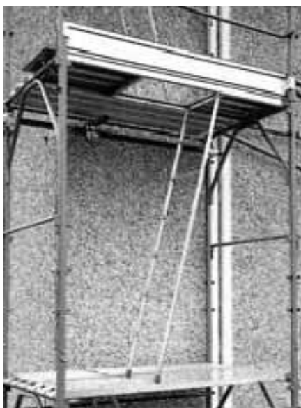
Fig. 9 – Sistema di salita prefabbricato
