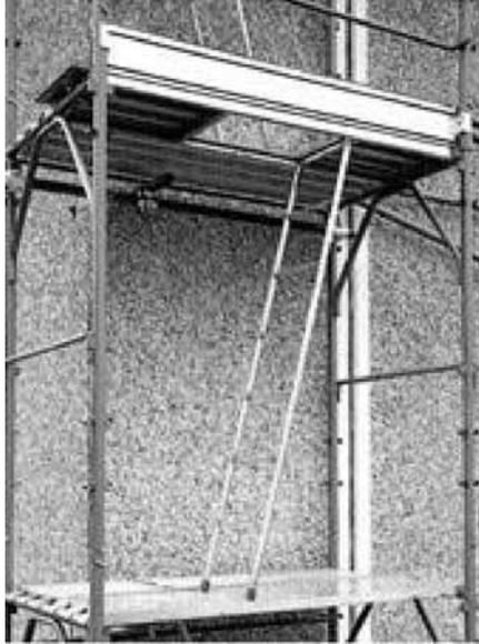
Fig. 9 – Sistema di salita prefabbricato
