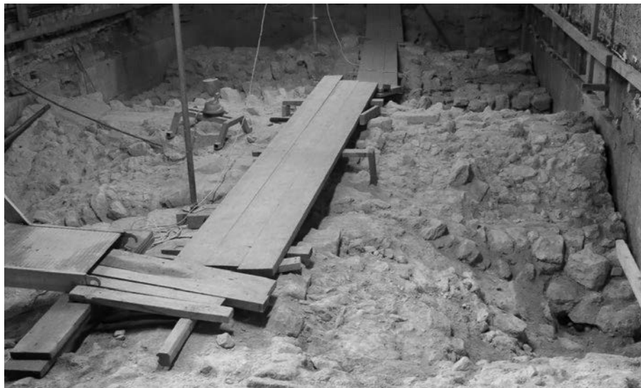
Figura 5.2. Vista dell'estradosso della copertura voltate del narcece.
