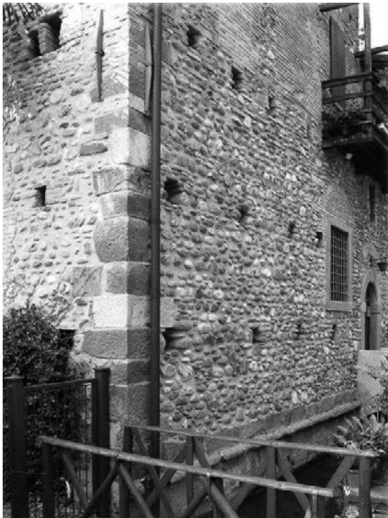
(a) Esempio di edificio in muratura tradizionale con cantonali in blocchi sbazzati ammassati alla muratura composta da ciottoli di fiume.
