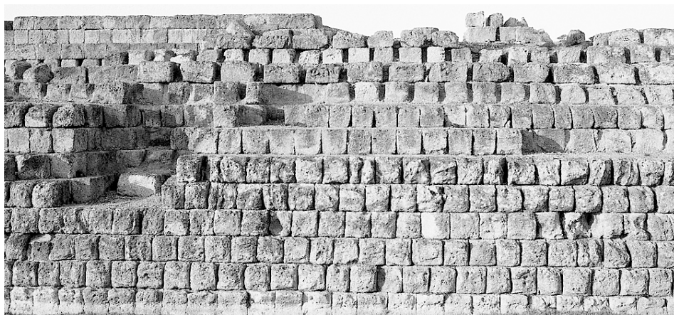
Muro di contenimento delle terre
