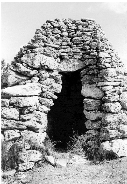
Esempio di muratura a secco, senza l'utilizzo del legante
