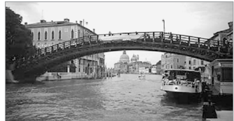
Fig. 17.2. Ponte dell'Accademia. Originariamente si presentava in legno ma con l'intervento di consolidamento effettuato nei primi anni '80, ha perso la sua singolare valenza a causa delle integrazioni in acciaio poste nella parte sottostante
