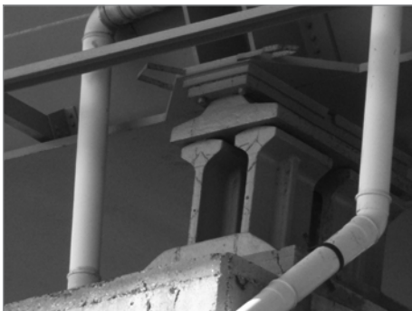
Fig. 7.3. Appoggio a cerniera in acciaio a lavagna
