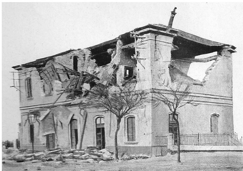
Figura 2.2. Case rovinate dal terremoto di Calabria del 28 dicembre 1908
