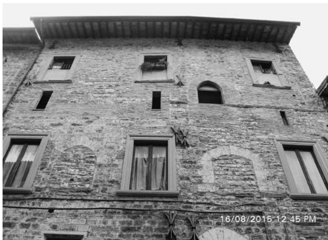
Figura 1.2. Esempio di muratura in pietra abbinata all'uso del mattone (Gubbio, foto di Sara Frumento)
