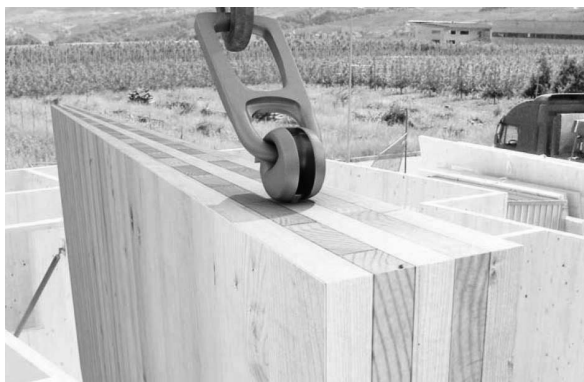
Figura 1.9. Vite VGS utilizzata a trazione per il collegamento degli ancoraggi di sollevamento dei pannelli [Fonte Rothoblaas]
